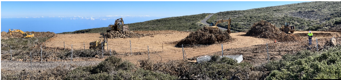
Plataforma definitiva LST4, se observa la creación de la escollera y el extendido y compactación de áridos sobre el terreno para su creación.
