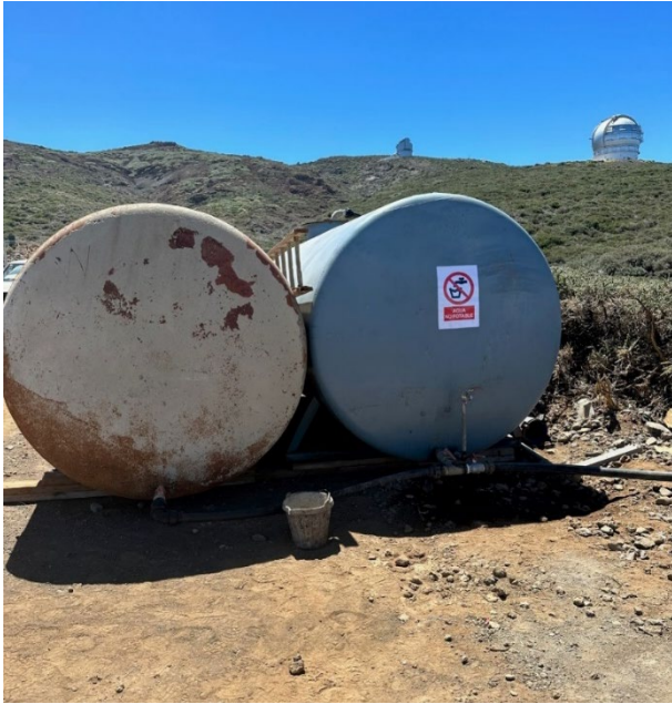
Depósito de agua no potable en la zona de los trabajadores para utilización en la hormigonera y LST2. A la izquierda depósito para riegos en zona LST3 y LST4
