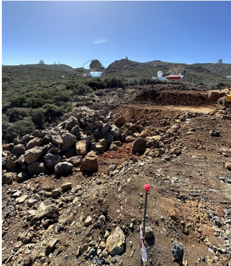
Formación escollera de plataforma definitiva del LST4
