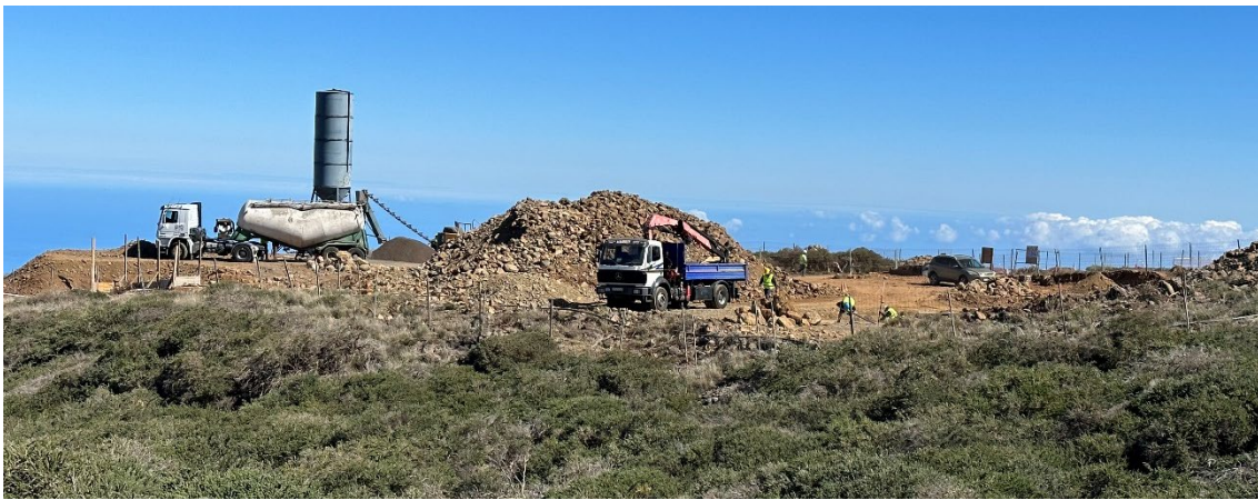
Descarga del cemento en la hormigonera
