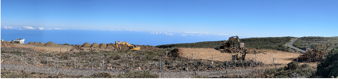
Panorámica LST3, donde se aprecia la plataforma auxiliar el acopio de pétreos para su extendido y elevación de la plataforma. A la derecha se observa la formación de la plataforma auxiliar del LST4.
