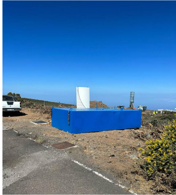
Depósito de agua no potable en la zona de los trabajadores para utilización en la hormigonera y LST2. A la izquierda depósito para riegos en zona LST3 y LST4
