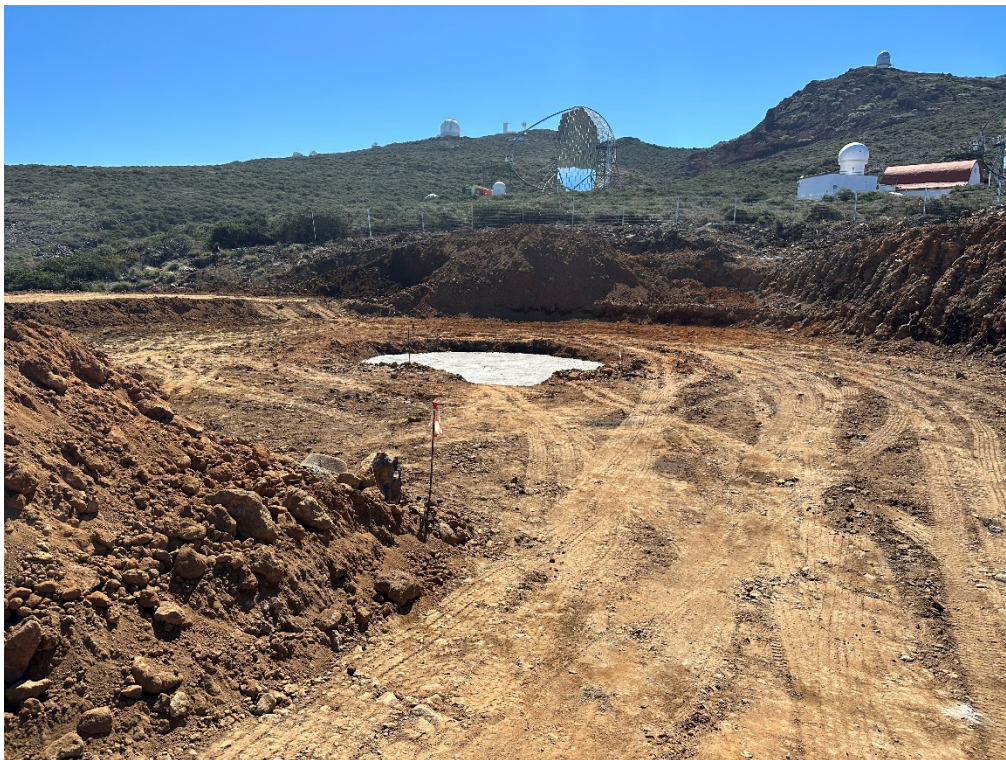
Hormigón de limpieza en el núcleo de lo que será la base del telescopio.
