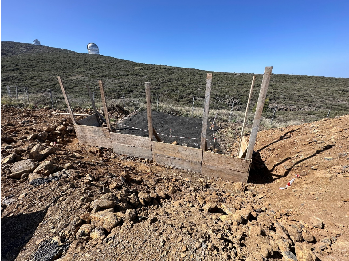
Comienzo encofrado zona de protección arqueológica
