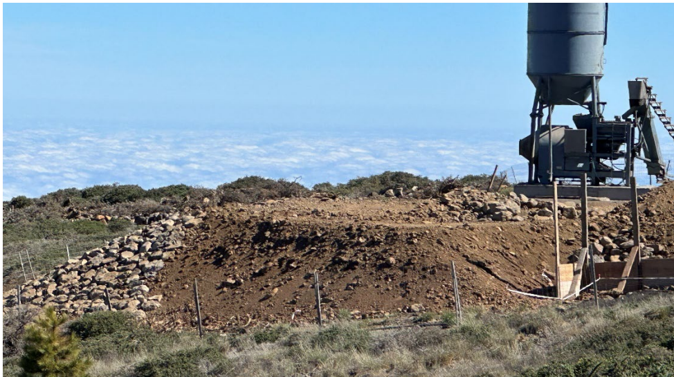
Colocación piedras sobre escollera de la plataforma auxiliar del LST2
