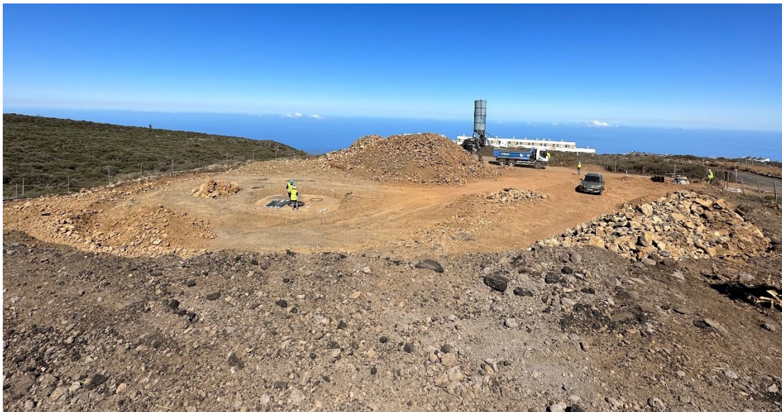
Plataforma LST2 y comienzo de la colocación de la jaula del núcleo central de apoyo del futuro telescopio
