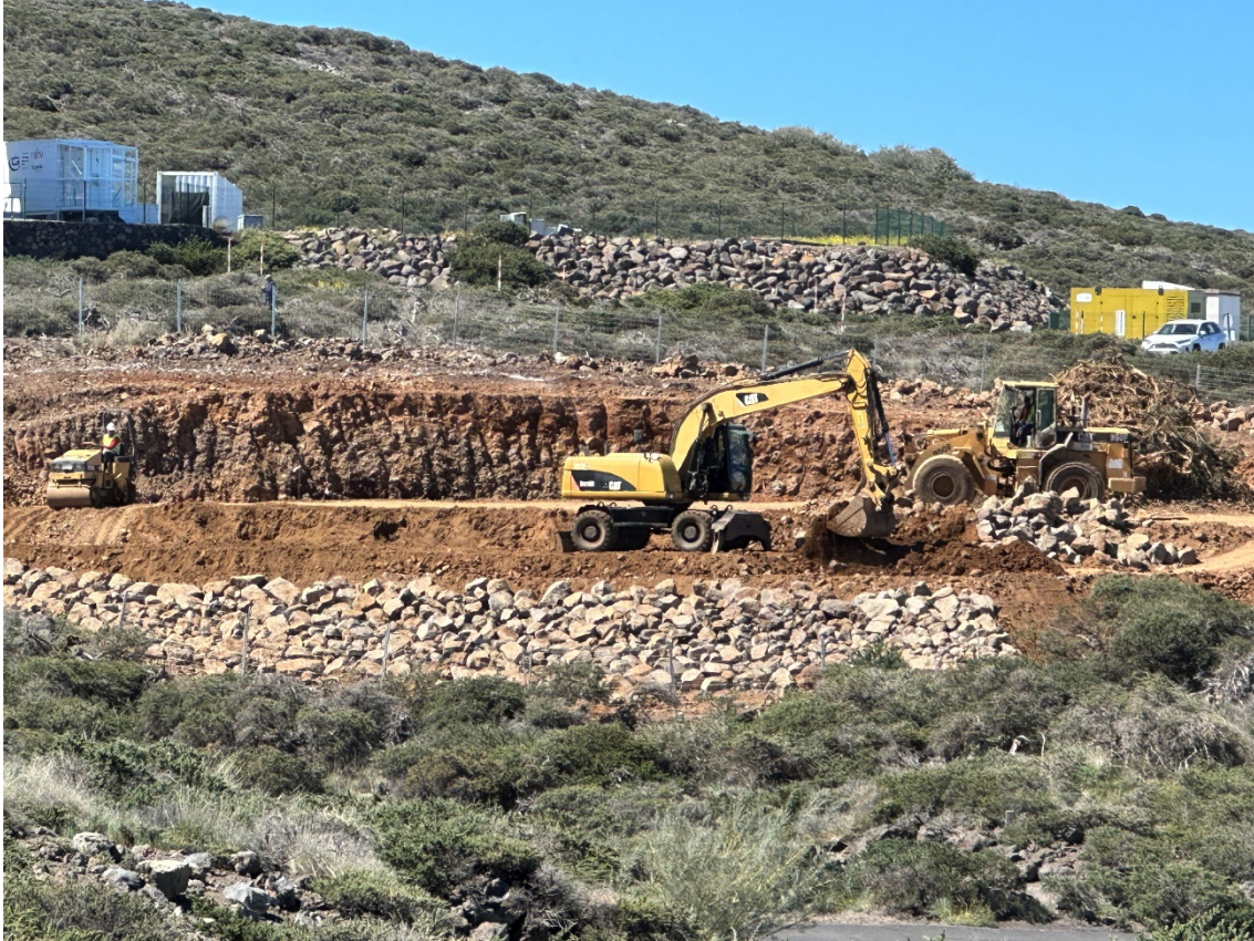
Plataforma definitiva LST4, se observa la creación de la escollera y el extendido y compactación de áridos sobre el terreno para su creación.
